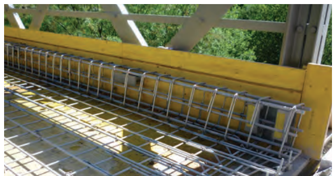
Blacktenbrücke, Bauma, Schweiz
