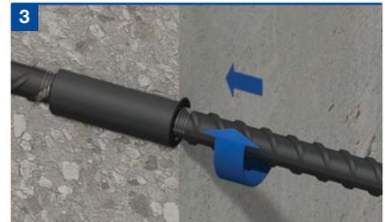
Den Anschlussstab bis zum Anschlag in die Kupplung einschrauben.
