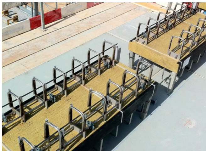
Vertikale Vordachanschlüsse auf Dachrand
