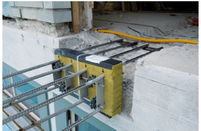
Anschluss an bestehendes Gebäude (mit Niveau-Versatz)
