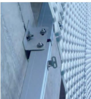
Befestigungselemente für Fassadenverkleidungen
