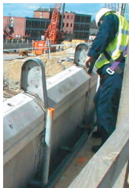
Dekorative Brückenabdeckungen mit Befestigungen. Projekt: Schienenanbindung Ärmelkanaltunnel, GB (Ausführendes Unternehmen: Carillion)
