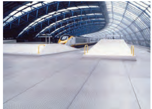
Projekt: Waterloo International Terminal, GB
