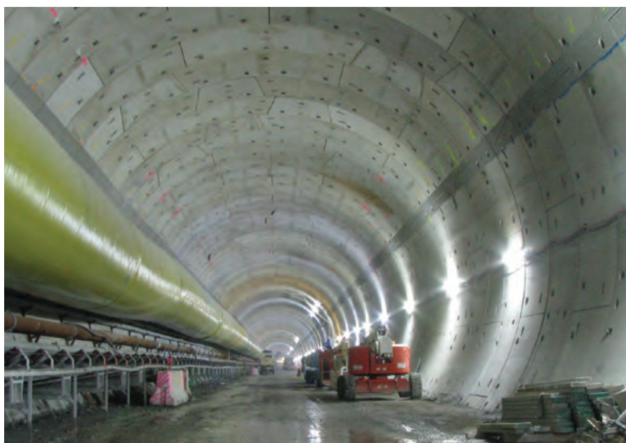
Projekt: Nord-Süd-Umgehung Brisbane, Australien (Ausführendes Unternehmen: LBB JV, Bauleitung: Bilfinger Berger)
