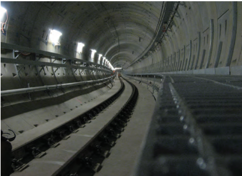
Wartungsstege. Projekt: U-Bahn-Tunnel Perth City, Australien (Ausführendes Unternehmen: Leighton Kumagai JV)
