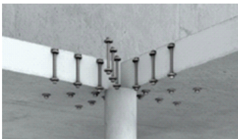
Bild 50: Durchstanzverstärkungssysteme a) nachträglich installierte Durchstanzbewehrung und b) nachträglich installierte Stützenkopfvergrößerung
