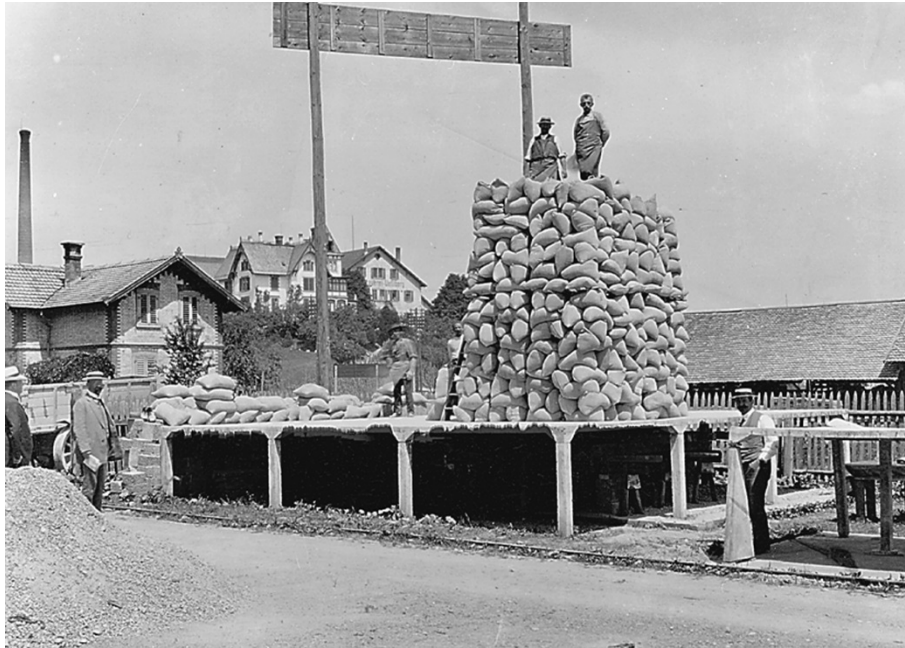
Bild 2: Erste Versuche mit unterzugslosen Decken um 1908
