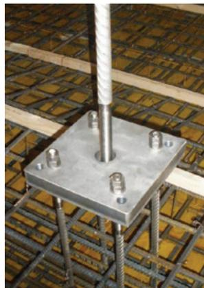
La sécurité étant d'importance primordiale dans les tunnels, un conduit d'aération au sommet du tunnel permettra d'évacuer l'air vicié, ou la fumée en cas d'incendie. Nous avons conçu et fabriqué un système de suspension en acier inoxydable pour l'immense plafond en béton qui se trouve au-dessous de ce conduit.
