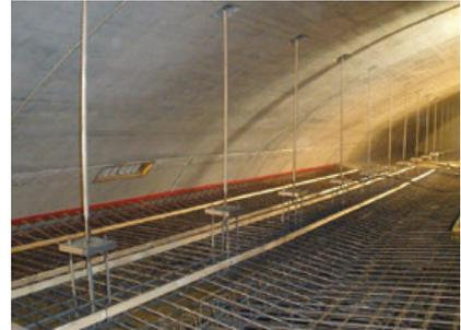
116 suspentes et plaques en acier inoxydable de nuance 1.4529 ont été livrées au chantier. Cet acier super-austénitique a été sélectionné pour sa très haute résistance à la corrosion. Chaque composant du système remplit une fonction structurelle essentielle et absorbe le mouvement, puisque les suspentes sont conçues pour permettre la rotation au niveau du plafond et du sol.
