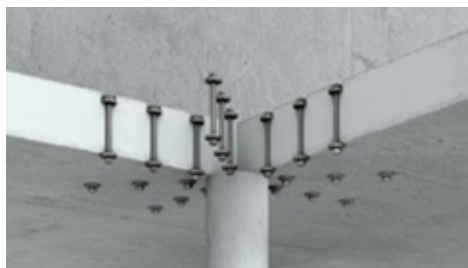
Ill. 50 : Systèmes de renfort de la résistance au poinçonnement a) armature de poinçonnement installée ultérieurement et b) augmentation de la taille de la tête de colonne installée ultérieurement
