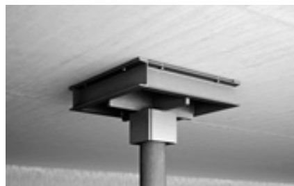
Ill. 50 : Systèmes de renfort de la résistance au poinçonnement a) armature de poinçonnement installée ultérieurement et b) augmentation de la taille de la tête de colonne installée ultérieurement
