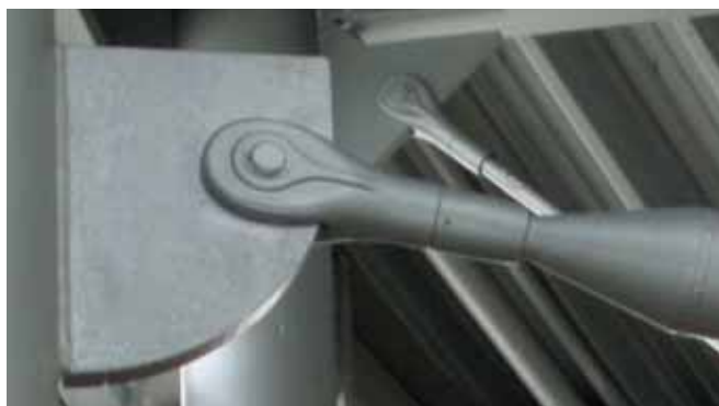
Système de compression raccordé à un gousset soudé
