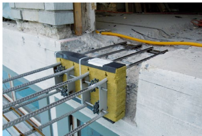
Collegamento all'edificio esistente (con saliente di livello).
