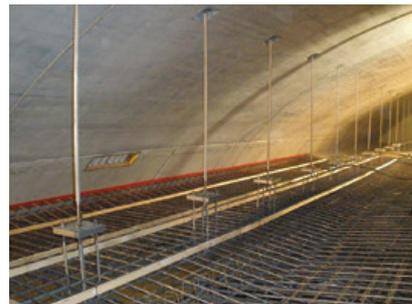
Sono stati realizzati 116 sistemi di aggancio e piastre in acciaio di qualità 1,4529. Questo acciaio inossidabile super austenitico è stato selezionato grazie alla sua altissima resistenza alla corrosione. Ciascun componente del sistema svolge una funzione strutturale essenziale e consente il movimento, poiché i sistemi di aggancio permettono la rotazione a livello del soffitto e del suolo.
