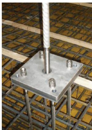
Data la massima importanza della sicurezza in galleria, un condotto di ventilazione nella calotta della galleria estrarrà l'aria contaminata o il fumo in caso d'incendio. Progettiamo e realizziamo un sistema di sospensione in acciaio inossidabile per la galleria del Graitery per sostenere l'enorme soffitto in calcestruzzo sotto questo condotto.
