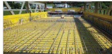
Con il nuovo NIRO22, Ancon si aggiudica la fornitura di armature in acciaio inossidabile per il progetto di questo prestigioso ponte: si tratta della prima volta che l'acciaio inossidabile viene impiegato in modo competitivo per un progetto di questa portata.
